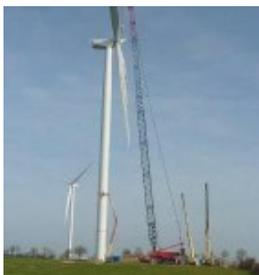
Mise en place d'une éolienne avec la grue
